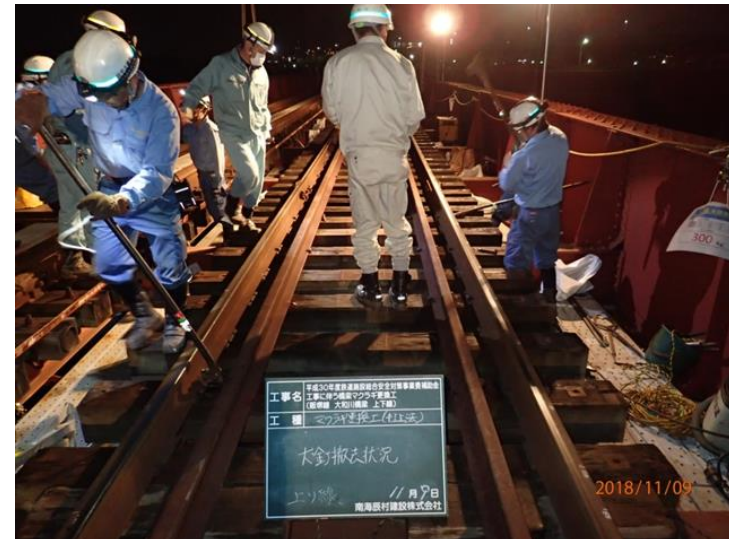
軌道改修工事状況
