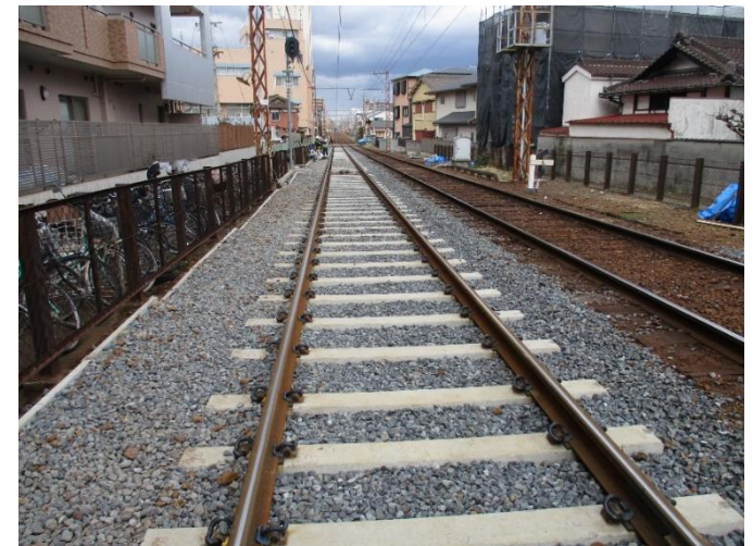
レール、枕木の更新【阪堺線】
