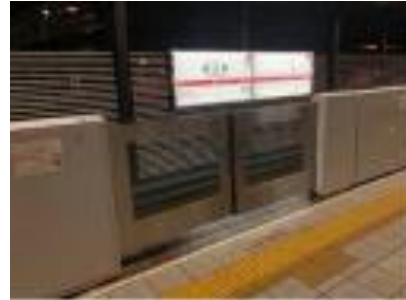
図表 可動式ホーム柵 資料：堺市
