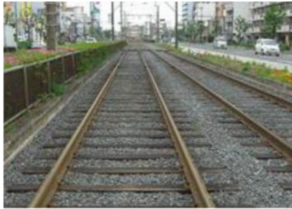
図表 更新した軌道 資料：堺市
