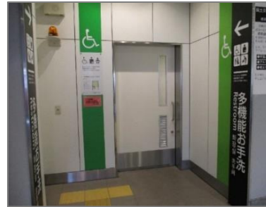
図表 多機能トイレの設置状況 JR 阪和線三国ヶ丘駅
