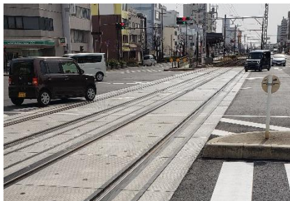
図表 更新した交差点内の軌道 資料：堺市
