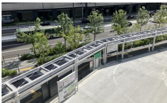
例：小規模な屋根を活用した次世代太陽電池の設置 (うめきたグリーンプレイス 駅前広場)
