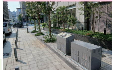
例：歴史案内版と一体化した無電柱化 の地上機器 (大阪市 道修町通)
