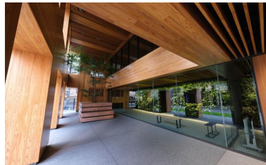
例：建物の構造体を木造化したビル （Port Plus大林組横浜研修所）
