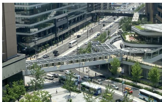
例：建物間をシームレスに移動できる歩行者デッキ (大阪駅西側エリア)
