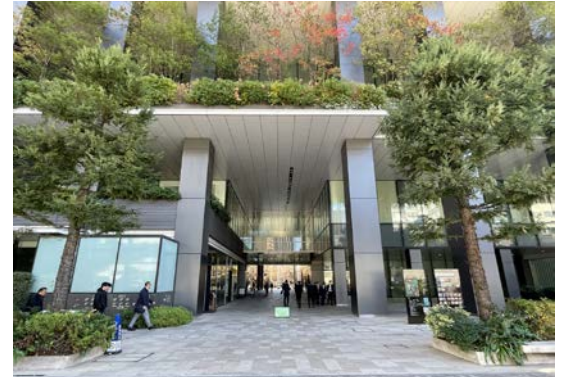
十分な天井高を確保し、視認性や快適性にも配慮した屋根がかり空間
