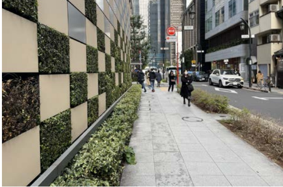
限られた空間で、壁面緑化により 緑化空間と歩行空間を確保
