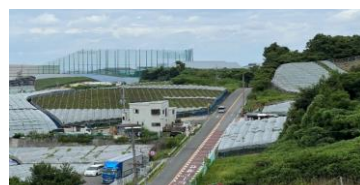
南河内フリースロード 提供:大阪府
