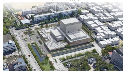
高槻城公園 提供:高槻市
