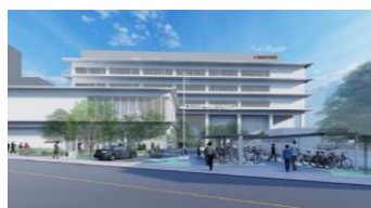
富田林市新庁舎建設プロジェクト 提供：富田林市
