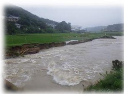
平成30年7月豪雨 河川増水による護岸の崩壊
