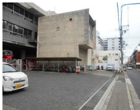
倉庫棟（写真②）
