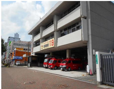
庁舎棟（写真①）
