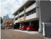
庁舎棟（敷地東側）
