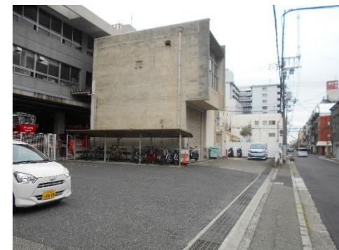
倉庫棟（写真②）
