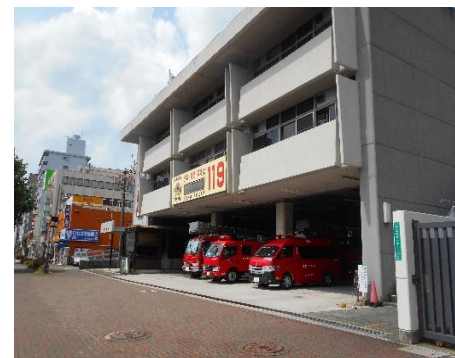
庁舎棟（写真①）
