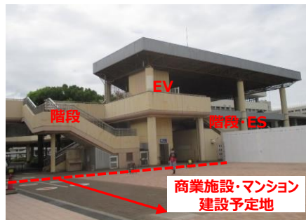
ペDESTリアンデッキ外観
