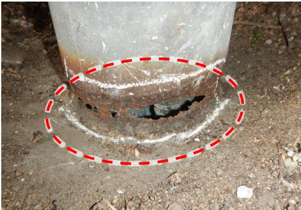
照明灯の根元の腐食
