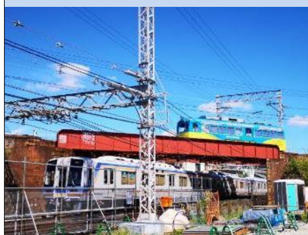
阪堺線立体交差状況
