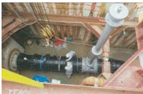
耐震管路φ900mm 布設状況
