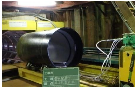
耐震管路φ1000mm 布設状況
