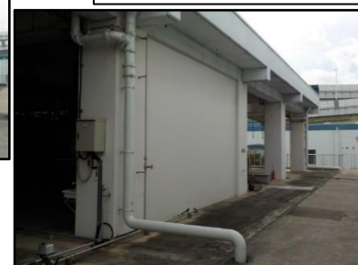
耐震化後（耐震壁設置）
