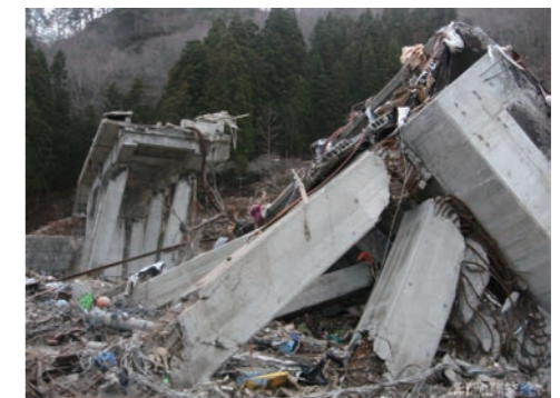
Estação de Shimanokoshi destruída Foto fornecida pelo Instituto de Segurança contra Incêndio e Preparação para Desastres
