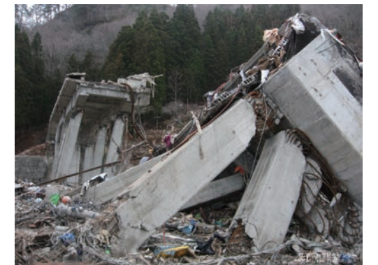
崩壊した島越駅
