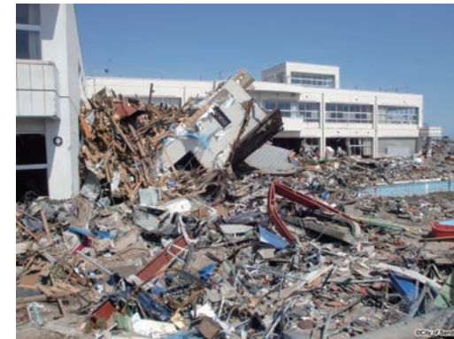
津波で校舎の高さまで積み上げられたがれき
