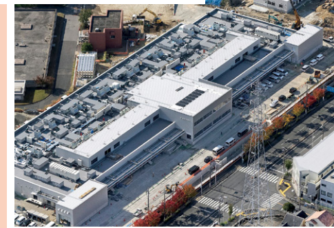
第1学校給食センターイメージ【上画像】／ 工事の進捗（ちよく）状況【下画像】
