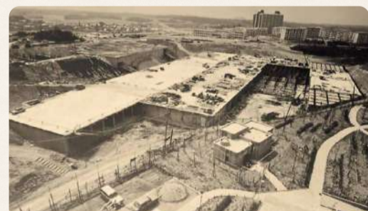
泉ヶ丘第3配水場(現・桃山台配水場)の築造工事
