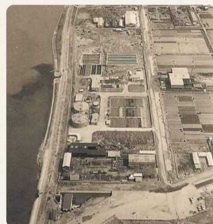
市で最初の下水処理施設、三宝下水処理場(現・三宝水再生センター)
