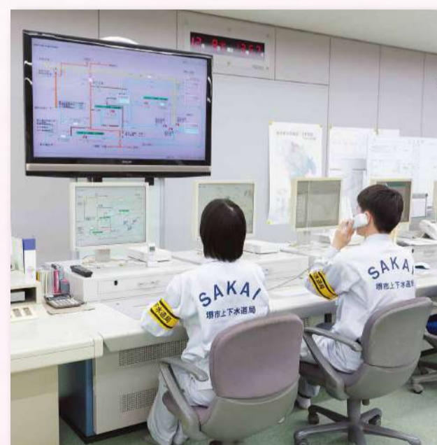
配水管理センターで市内すべての水道の配水状況を監視
