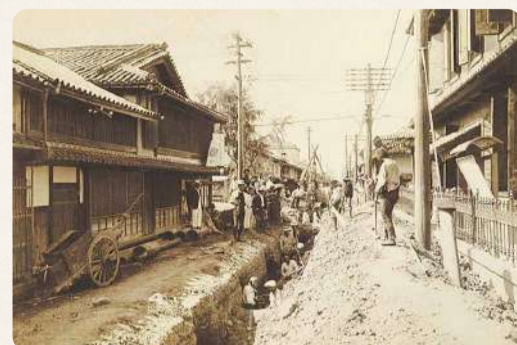
大道筋での水道敷設工事の様子
