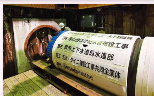
水道管を通すためのトンネルを掘るシールドマシン
