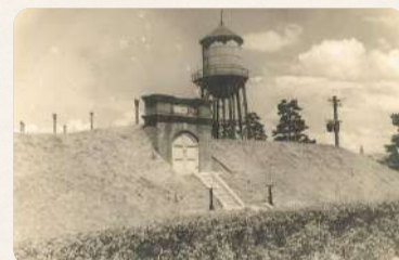
水不足に備えて築造された天王野水池
