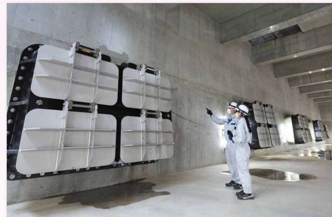
建設中の古川下水ポンプ場
