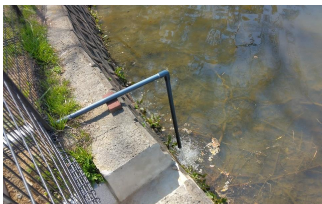
水循環を促す給水用井戸の設置
