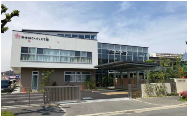
令和4年度整備施設（北区）
