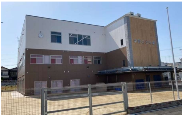
令和3年度整備施設（中区）
