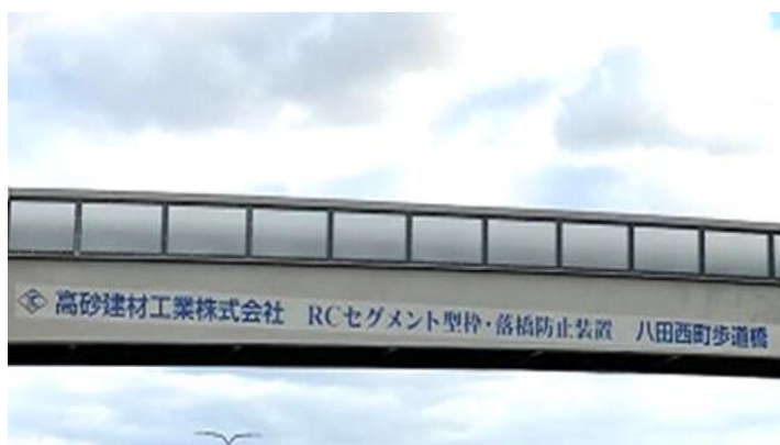
高砂建材工業株式会社 RCセグメント型枠・落橋防止装置 八田西町歩道橋（府道 堺かつらぎ線）
