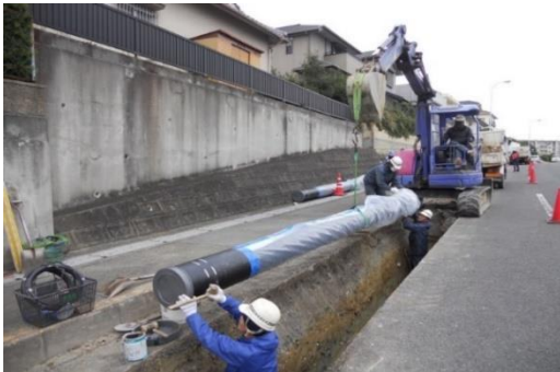
水道管（配水支管）の更新
