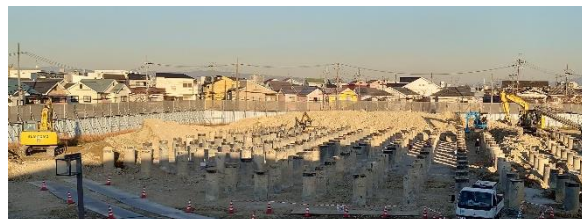
工事施工中の状況
