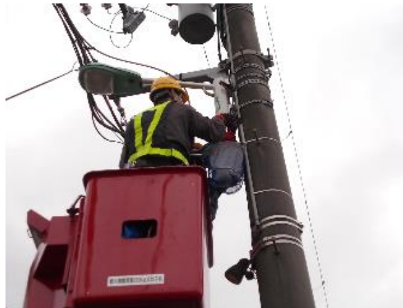
道路照明灯点検
