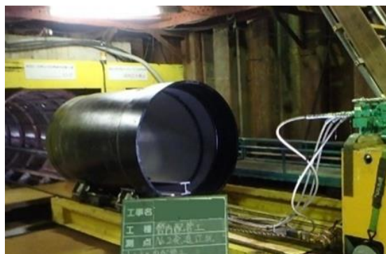
耐震管路φ1000mm 布設状況
