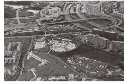
泉北ニュータウン開発 (泉ヶ丘駅付近)
