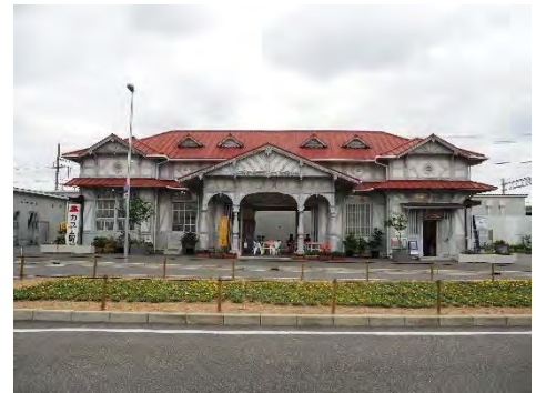
浜寺公園駅駅舎
