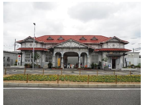
浜寺公園駅駅舎
