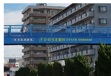
ひのうえ眼科 なかもず院 長曽根東歩道橋
