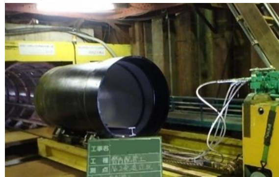
耐震管路φ1000mm 布設状況
