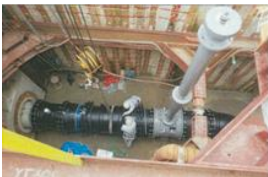
耐震管路φ900mm 布設状況
