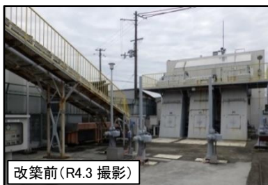
改築前(R4.3撮影) 沈砂池設備(戒橋下水ポンプ場)
