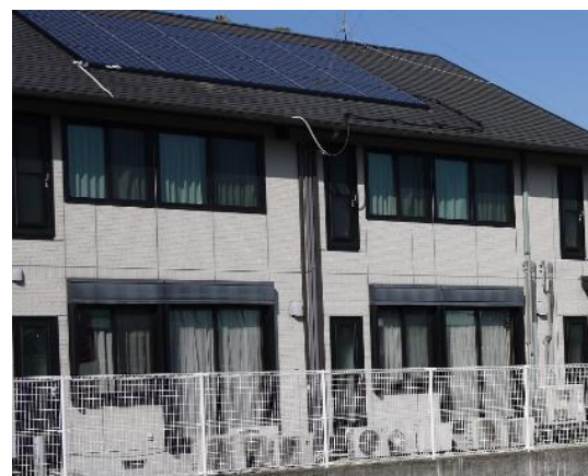
(参考) 関西電力異実験センター
