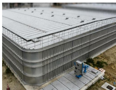
（工事後）ステンレス製配水池
