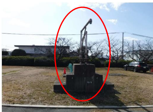
（工事前）応急給水栓 2 基
