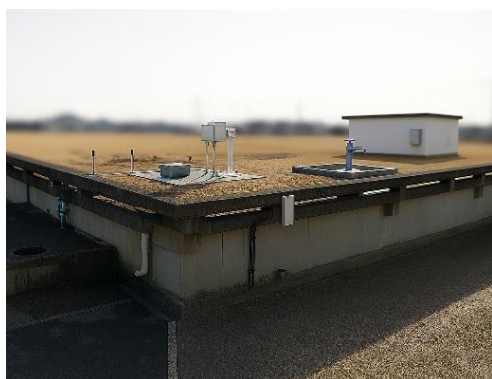
（工事前）コンクリート製配水池
