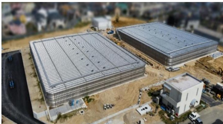
家原寺配水場（左が北側配水池、右が南側配水池）
