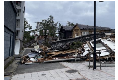
建物倒壊による道路閉鎖（能登半島地震）
