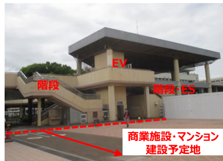
ペDESTリアンデッキ外観
