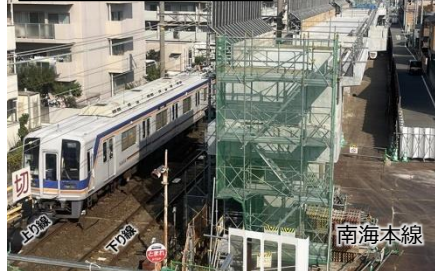
写真①：高架工事の状況 (床版築造)
