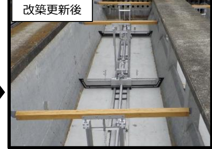
泉北水再生センター最終沈殿池設備
