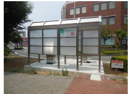
寄贈いただいた喫煙所設備
