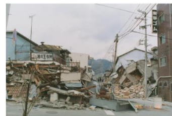
建物倒壊による道路閉鎖（神戸市）
