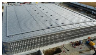
工事実施状況 （令和6年12月撮影）
