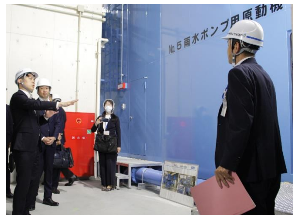
古川下水ポンプ場 場内視察の様子
