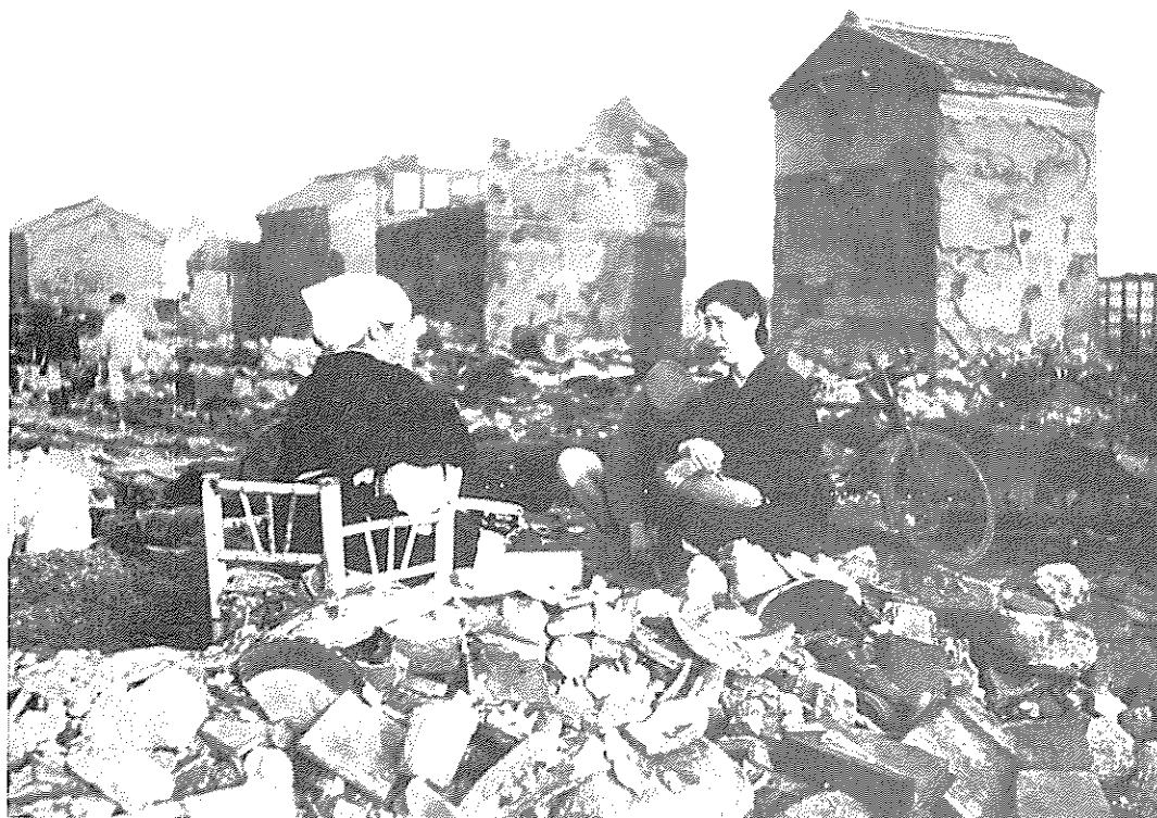
壕生活 5次におたる空襲で市街地の大半が焼野原になった。家屋を失った多くの人たちは、防空壕に焼トタンなどを囲って壕生活を余儀なくされた。
