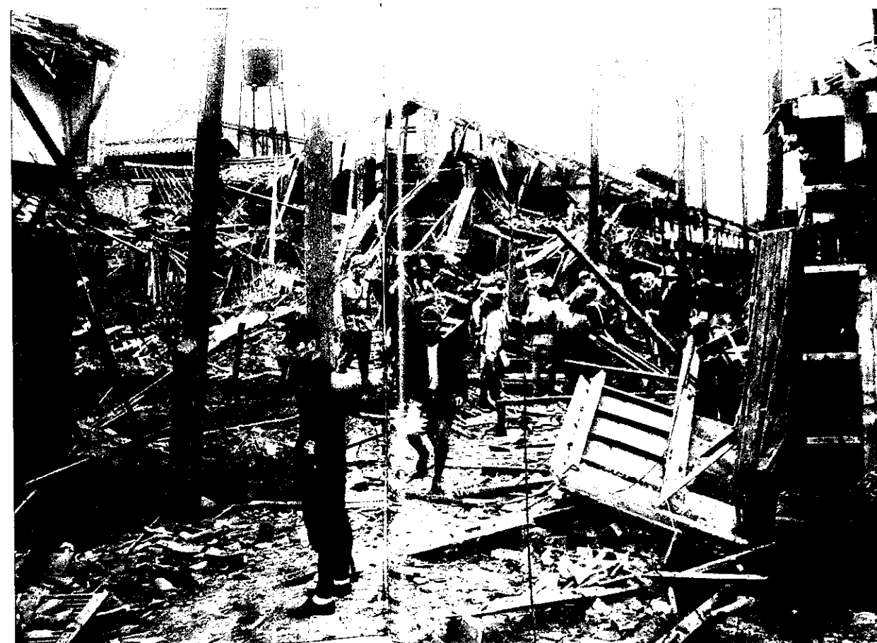
爆弾による被災 第3次空襲(6月26日) 柳屋町中浜付近。
