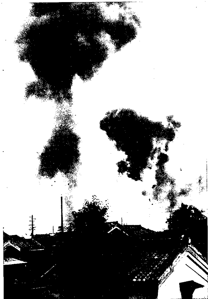
1トン爆弾が炸裂する戎島町2丁付近 6月26日(第3次空襲)
