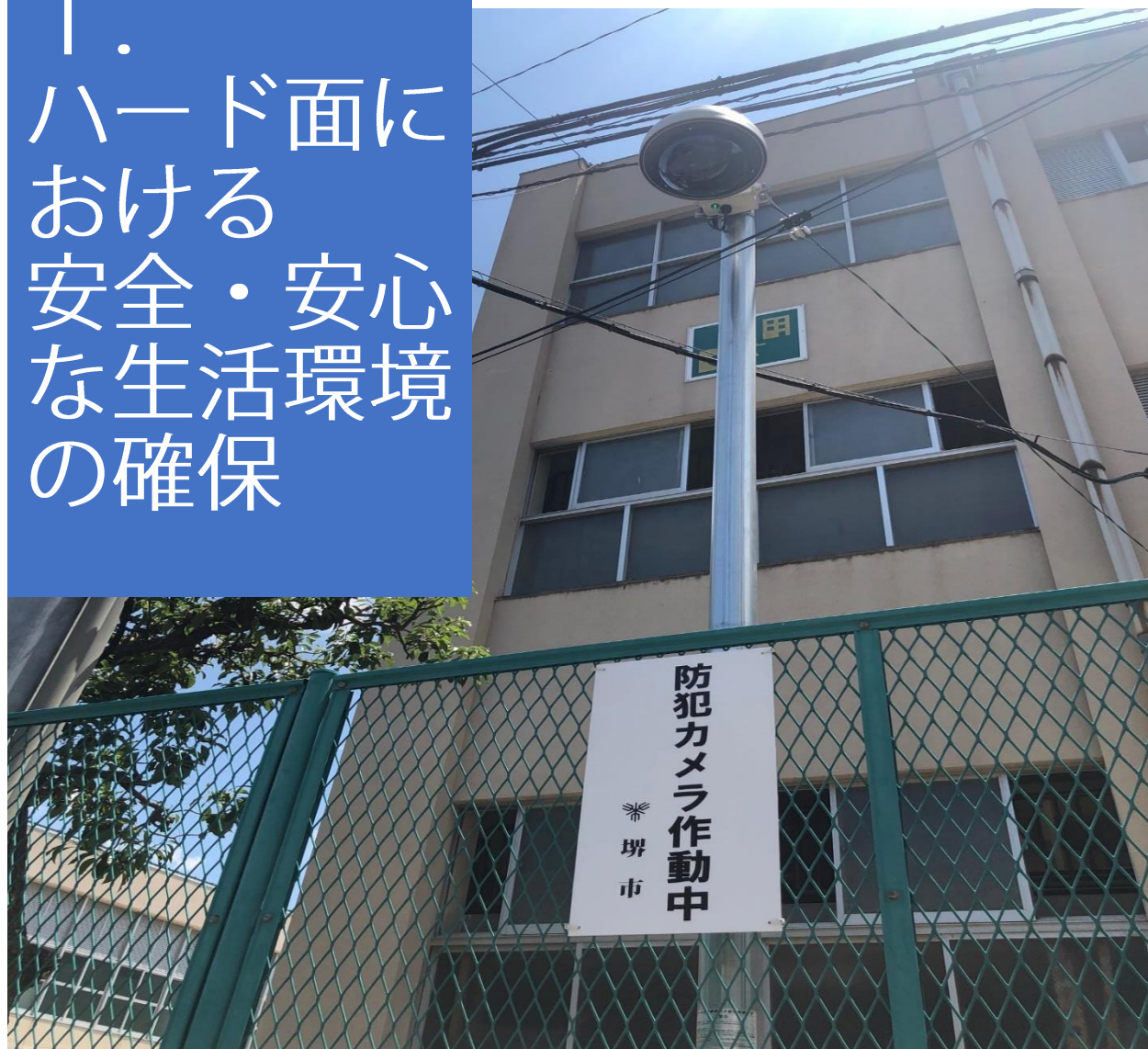
中学校に設置された街頭防犯カメラ
