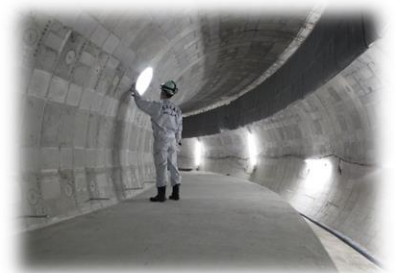
下水道管の工事
