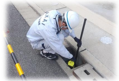
下水道管の調査
