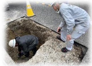
水道管修繕工事監督
