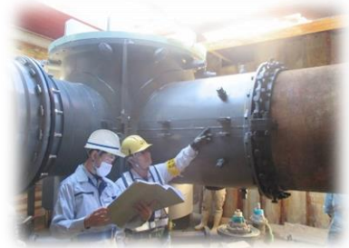
水道管の工事
