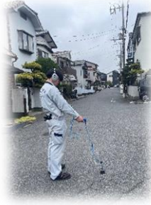
機器による漏水調査
