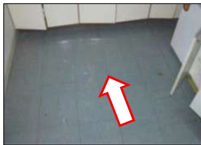
アスベスト含有ビニル床タイル（床仕上材）
