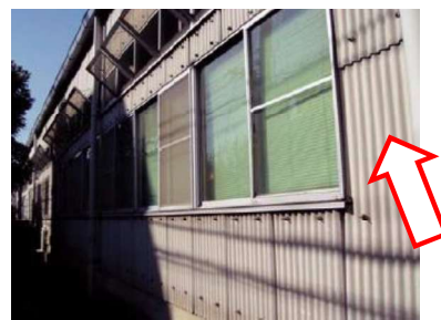
アスベスト含有スレート波板（外壁仕上材）
