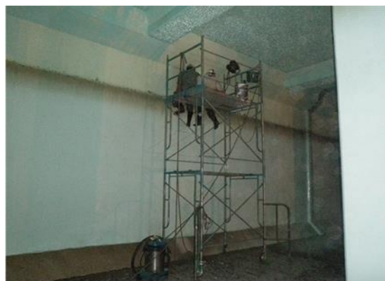
配水池内の点検・調査
