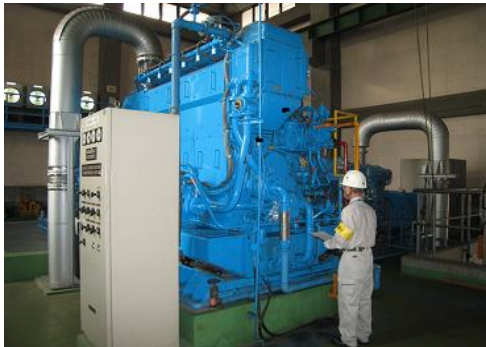
内川排水機場年次点検状況
