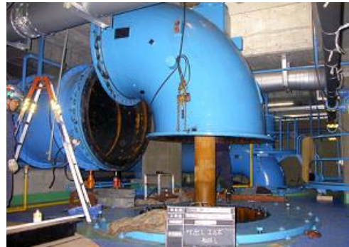
内川排水機場 2 号ポンプ整備状況（予防保全）
