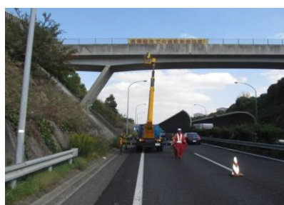
橋りょう点検
