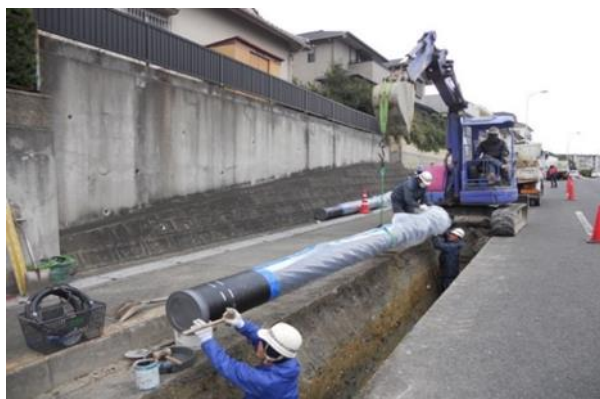
水道管の更新
