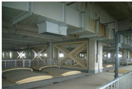
施設耐震化工事
