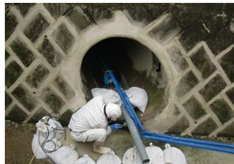
護岸補修状況
