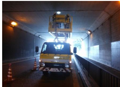
トンネル点検
