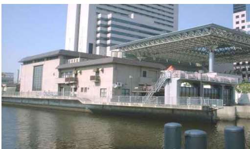
■内川排水機場（堺区戎島町）
