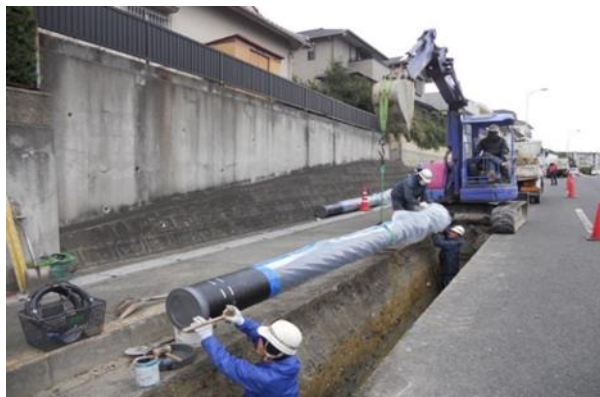
水道管の更新
