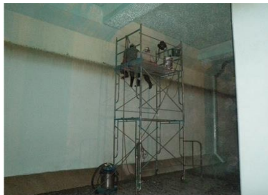
配水池内の点検・調査
