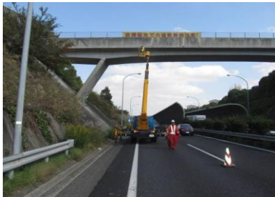
橋りょう点検
