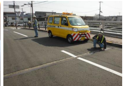
日常点検（パトロール）
