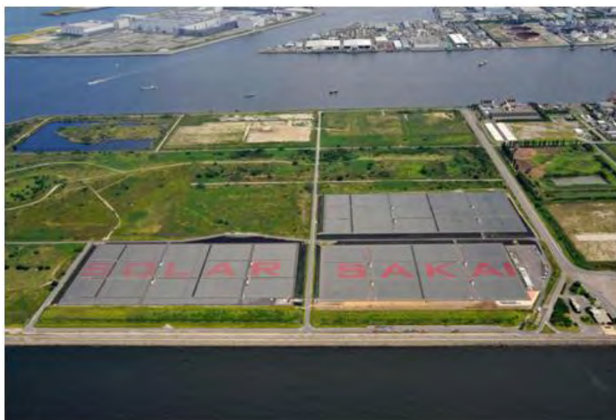
堺太陽光発電所
