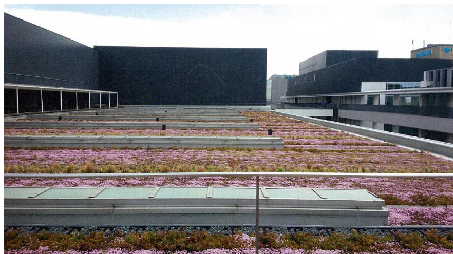
工場屋上の休憩テラスに広大な緑化庭園を設ける
