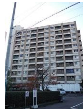
住宅地区改良事業等 大浜高層住宅建替事業 (大浜高層住宅解体工事)
