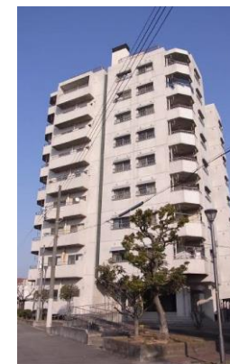
住宅地区改良事業等 協和町・大仙西町住宅建替事業 (協和町西団地16号館解体工事)
