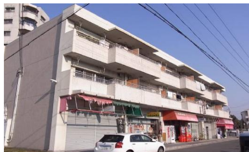
住宅地区改良事業等 協和町・大仙西町住宅建替事業 (協和町西団地15号館解体工事)
