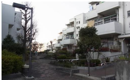
住宅地区改良事業等 協和町・大仙西町住宅建替事業 (大仙西町団地5～14棟解体工事)
