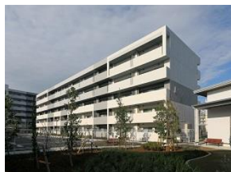
公営住宅整備事業等 万崎住宅建替事業 (万崎住宅A棟建設工事)
