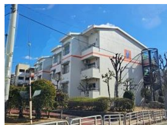
住宅地区改良事業等 外壁改修工事 (協和町西団地19号館)
