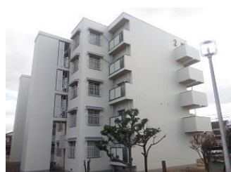
公営住宅整備事業等 外壁改修工事 (上野芝住宅2棟)
