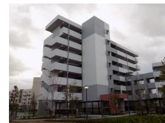
公営住宅整備事業等 万崎住宅建替事業 (万崎住宅D棟建設工事)
