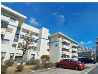
住宅地区改良事業等 外壁改修工事 (協和町東団地8号館)
