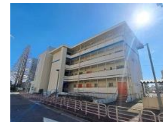
住宅地区改良事業等 昇降機棟増築工事 (協和町東団地11号館)
