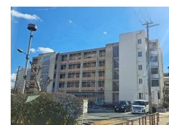
住宅地区改良事業等 昇降機棟増築工事 (協和町西団地13号館)
