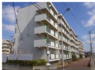
公営住宅整備事業等 外壁改修工事 (上野芝住宅1棟)
