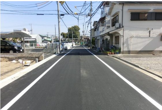
住宅市街地総合整備事業 (密集住宅市街地整備型) (地区公共施設整備)
