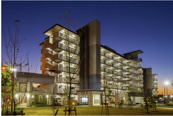
住宅地区改良事業等 協和町・大仙西町住宅建替事業 (大仙西町住宅A~D棟建設工事) (外観)
