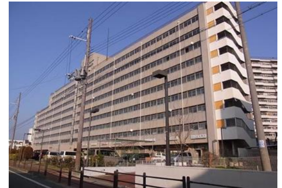
住宅地区改良事業等 協和町・大仙西町建替事業 (大仙西町住宅4棟解体工事)
