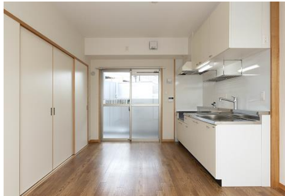
住宅地区改良事業等 協和町・大仙西町住宅建替事業 (大仙西町住宅A~D棟建設工事) (内部)
