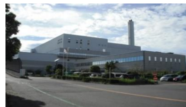
東工場第二工場
