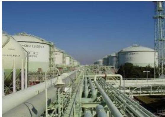
大阪ガス（株）泉北製造所
